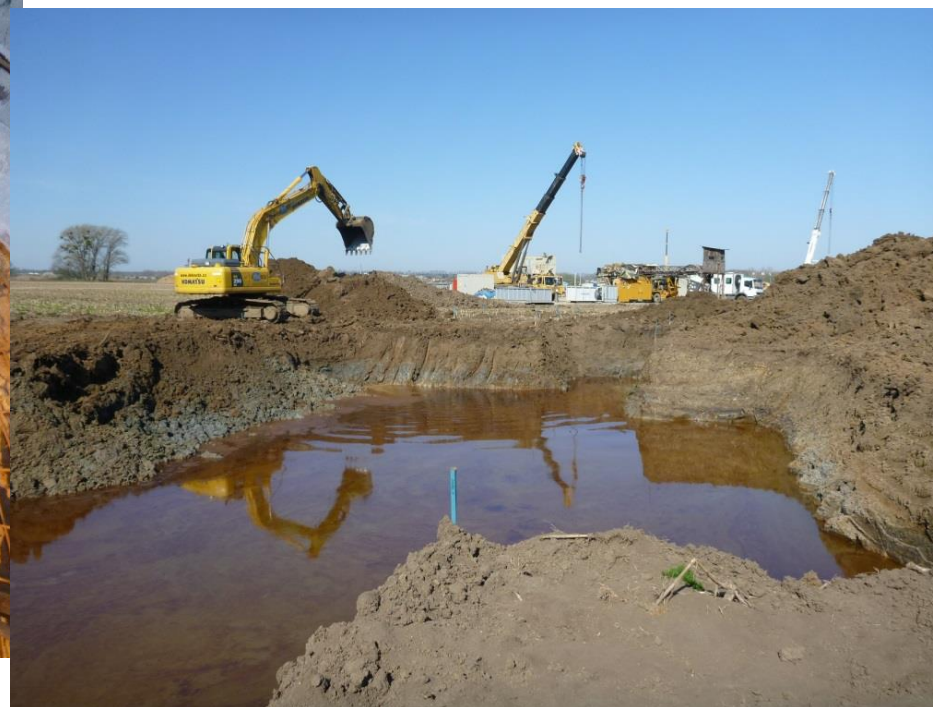
Odstranění starých ekologických zátěží po těžbě ropy v prostoru jímacího území Moravská Nová Ves – CHOPAV Kwartér řeky Moravy
