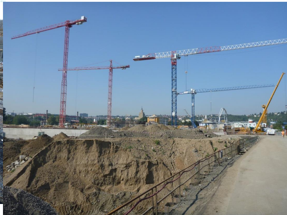
Pohled stavbou NVL na jejím počátku
