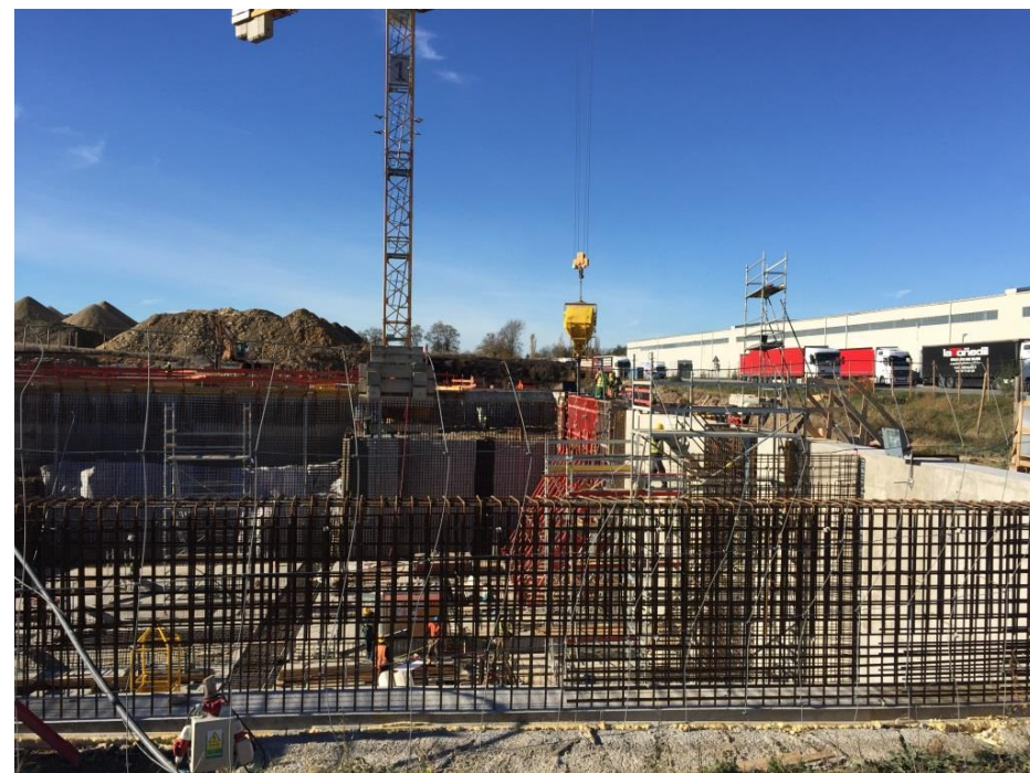
Letiště Praha – ČOV SEVER armování stěn retenční nádrže
