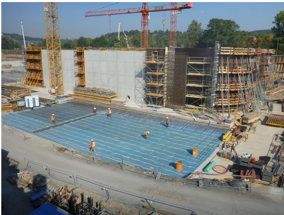
ÚČOV Praha – NVL – výstavba biolinek
